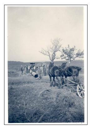
Einsatz von Trecker und Pferdefuhrwerk beim Rohrtransport für die 500-mm-NW-Wasserleitung von Baddeckenstedt über Gustedt nach Haverlahwiese, 1938 oder 1939.
